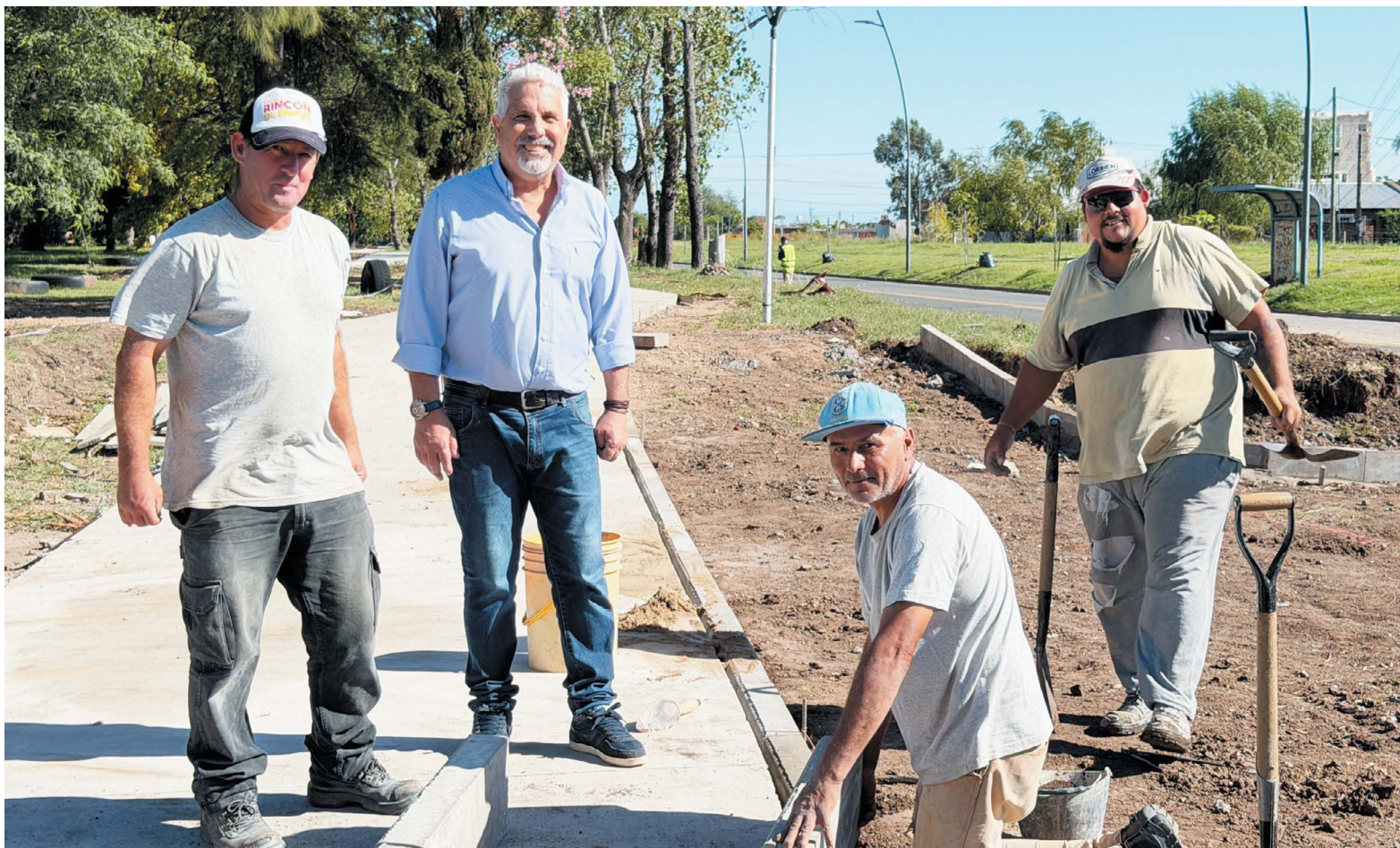
Berti destacó cómo quedará el espacio una vez finalizados los trabajos.
