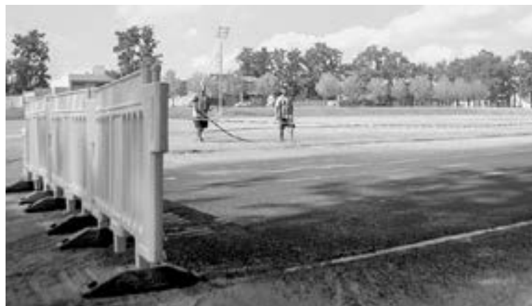
En los últimos días se pudo ver los trabajos en la pista.
