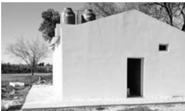
Los nuevos baños y vestuarios serán linderos a la nueva cancha de hockey.
