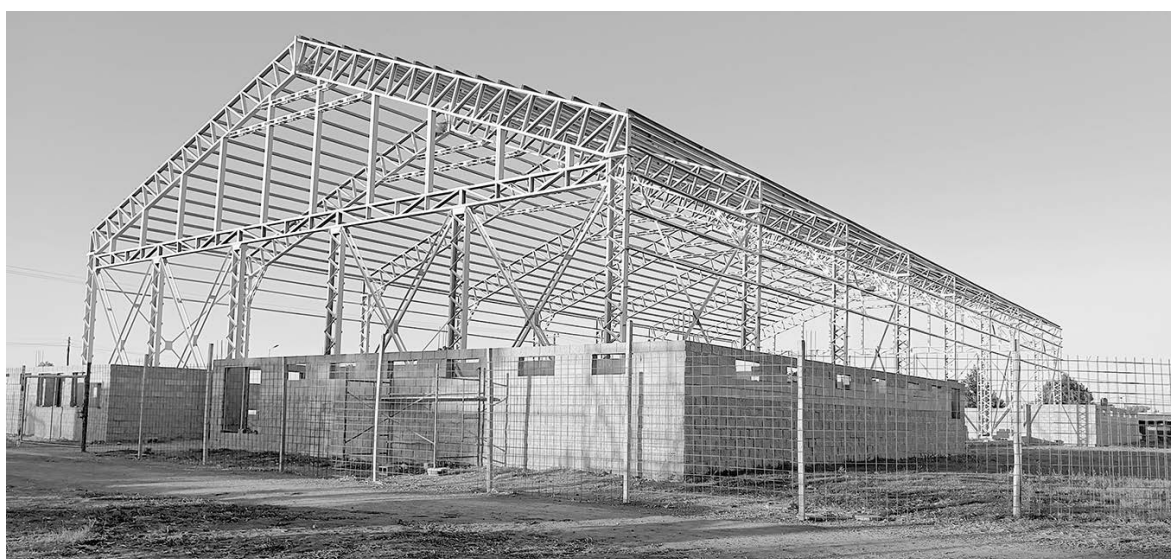
La obra del gimnasio cubierto continúa según lo estipulado.
