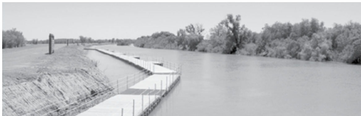
Se construyó un muelle de 200 metros.
